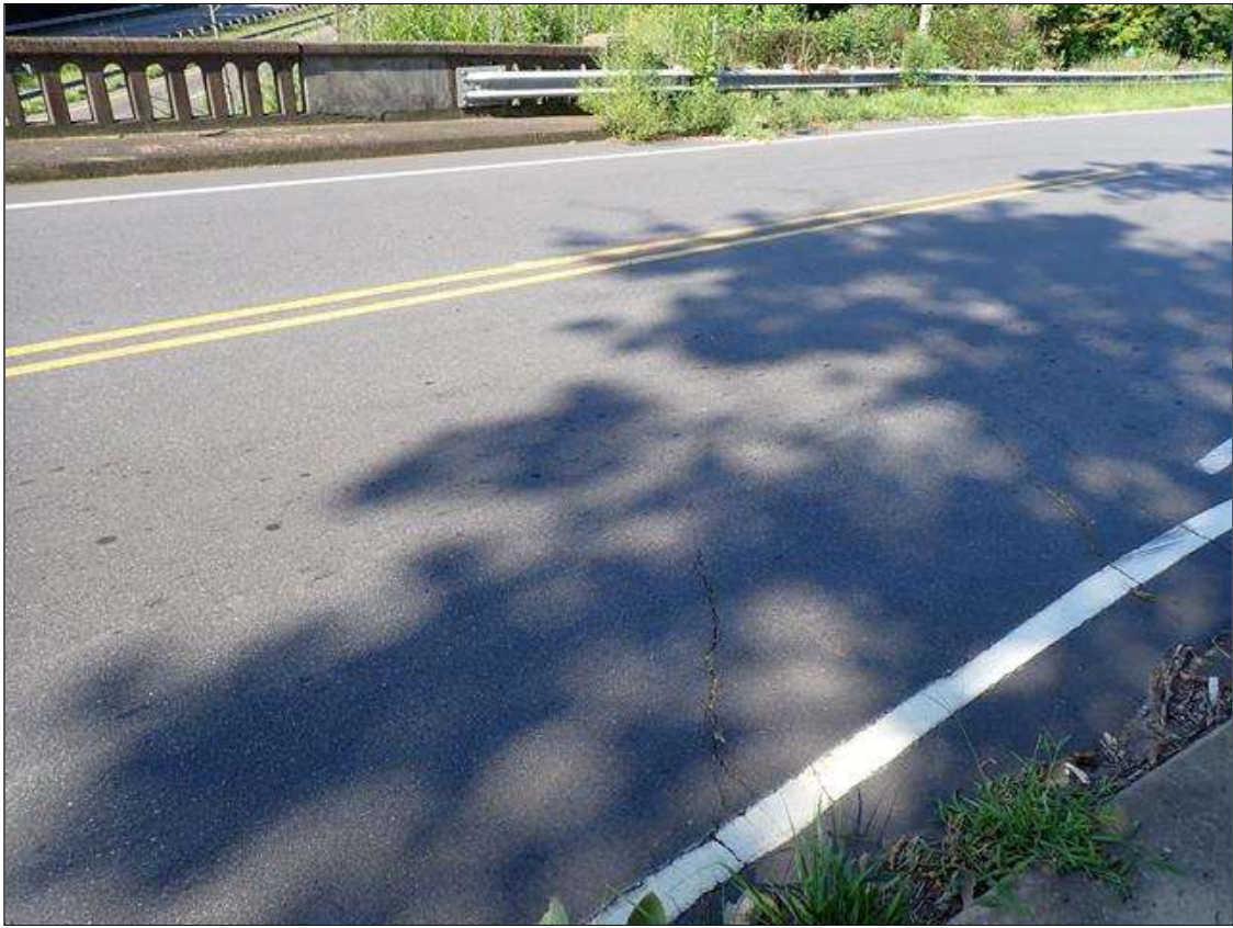
end bent 2 asphalt
