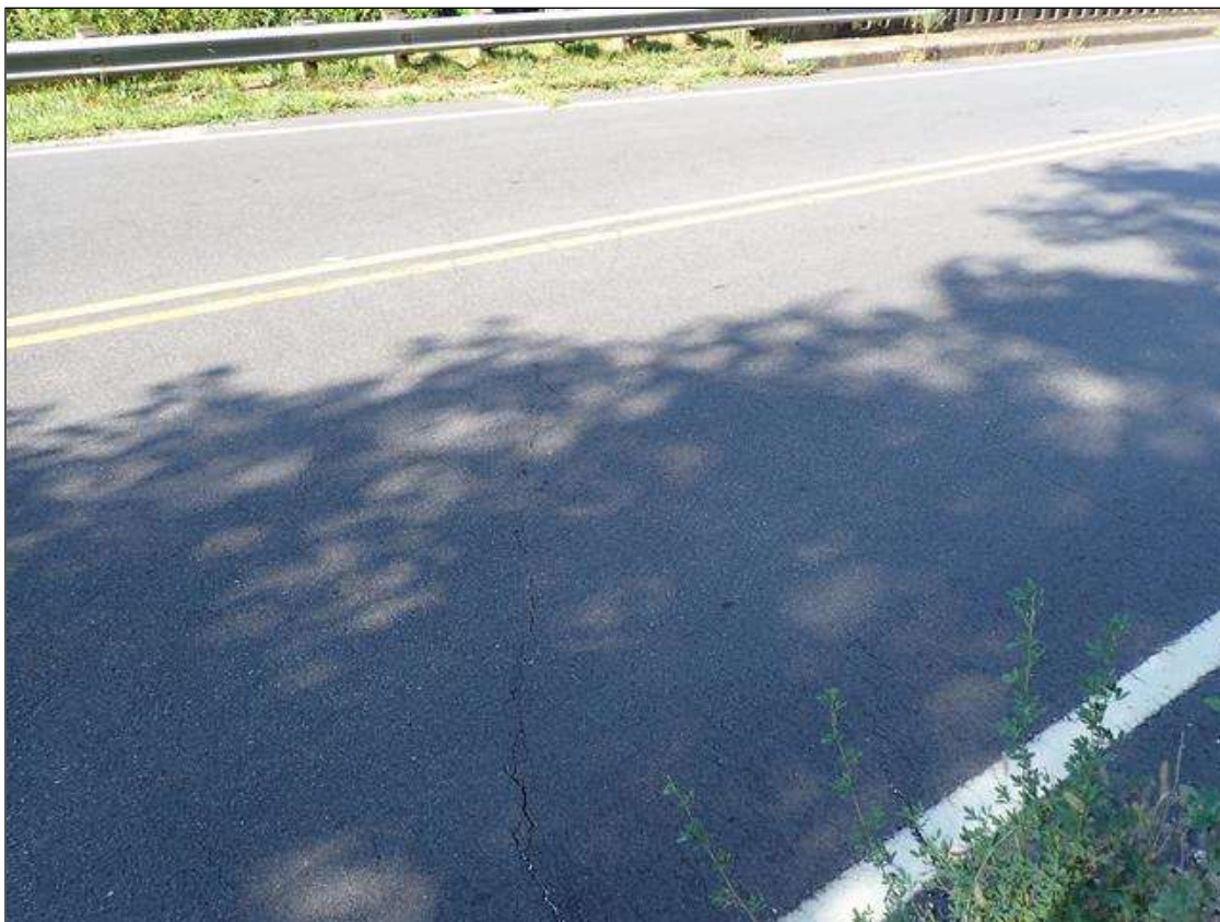
end bent 1 asphalt
